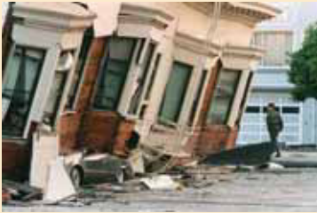
Edificio de departamentos colapsado en San Francisco, 18 de octubre de 1989, al día siguiente del terremoto masivo de Loma Prieta
