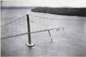
FIGURA 1 Colapso del puente de Tacoma Narrows
