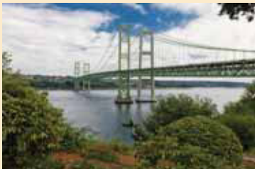
Puente Tacoma Narrows reconstruido (1950) y el nuevo puente paralelo (2009)
